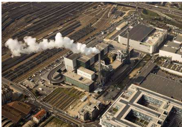
Centre de tri et de valorisation énergétique d'Ivry-Paris XII (photo : Syctom)
